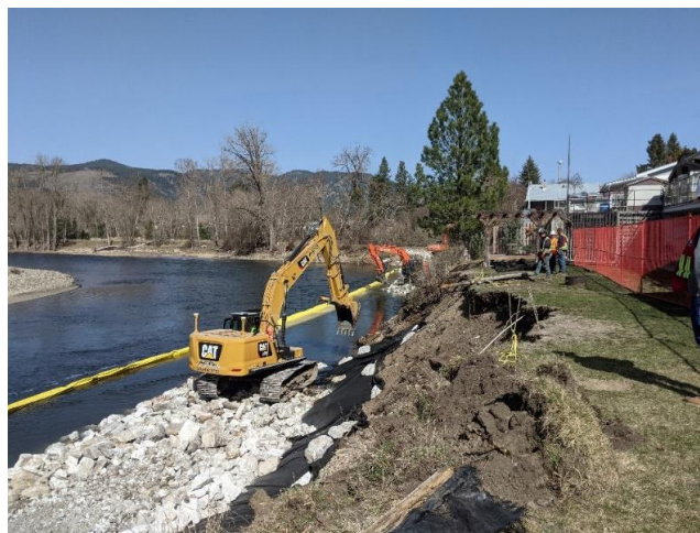
Installation d'un revêtement sur la rivière Kettle pour freiner l'érosion après les crues de 2018 et de 2020.
