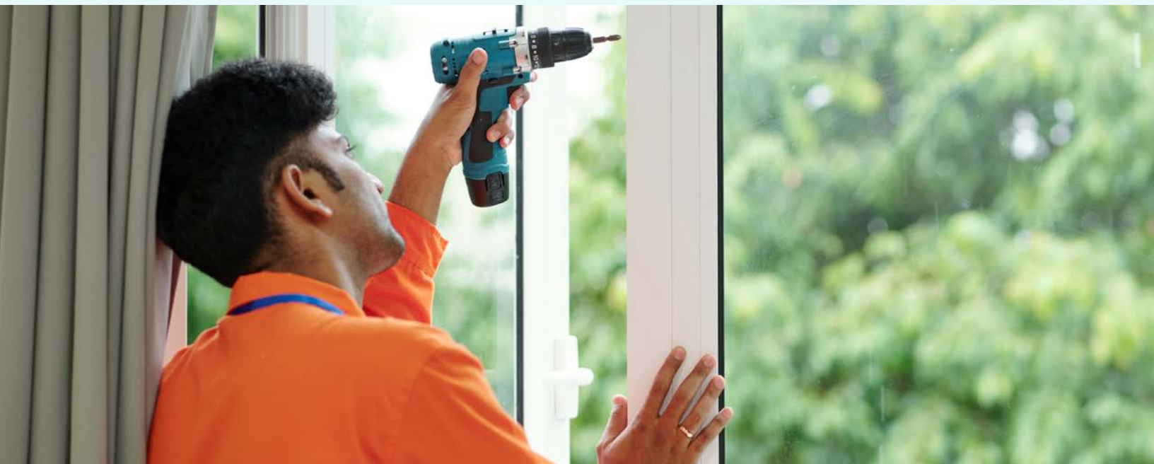
Ouvriers installant des fenêtres
